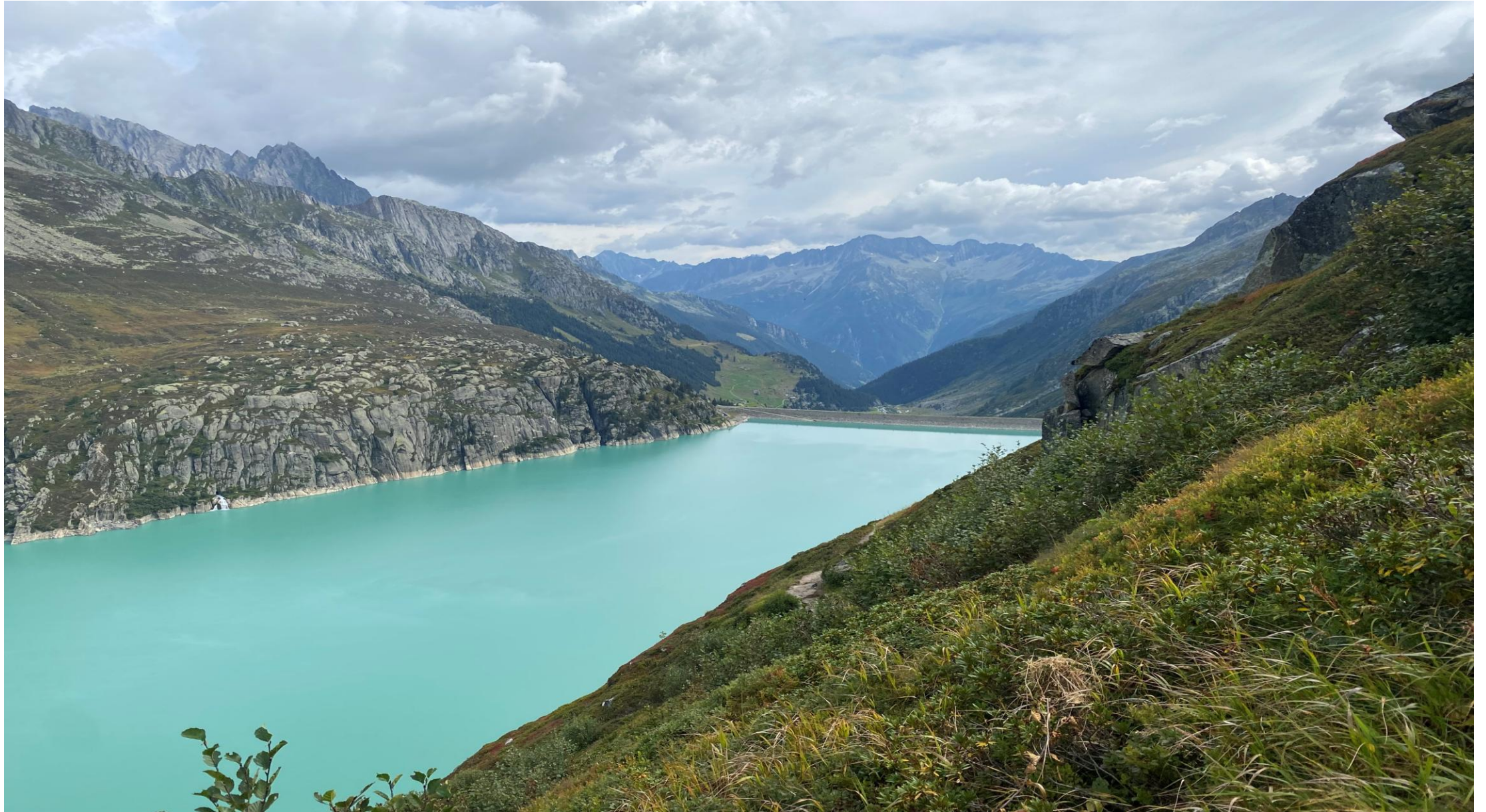
Erhöhung Staumauer Göscheneneralp
